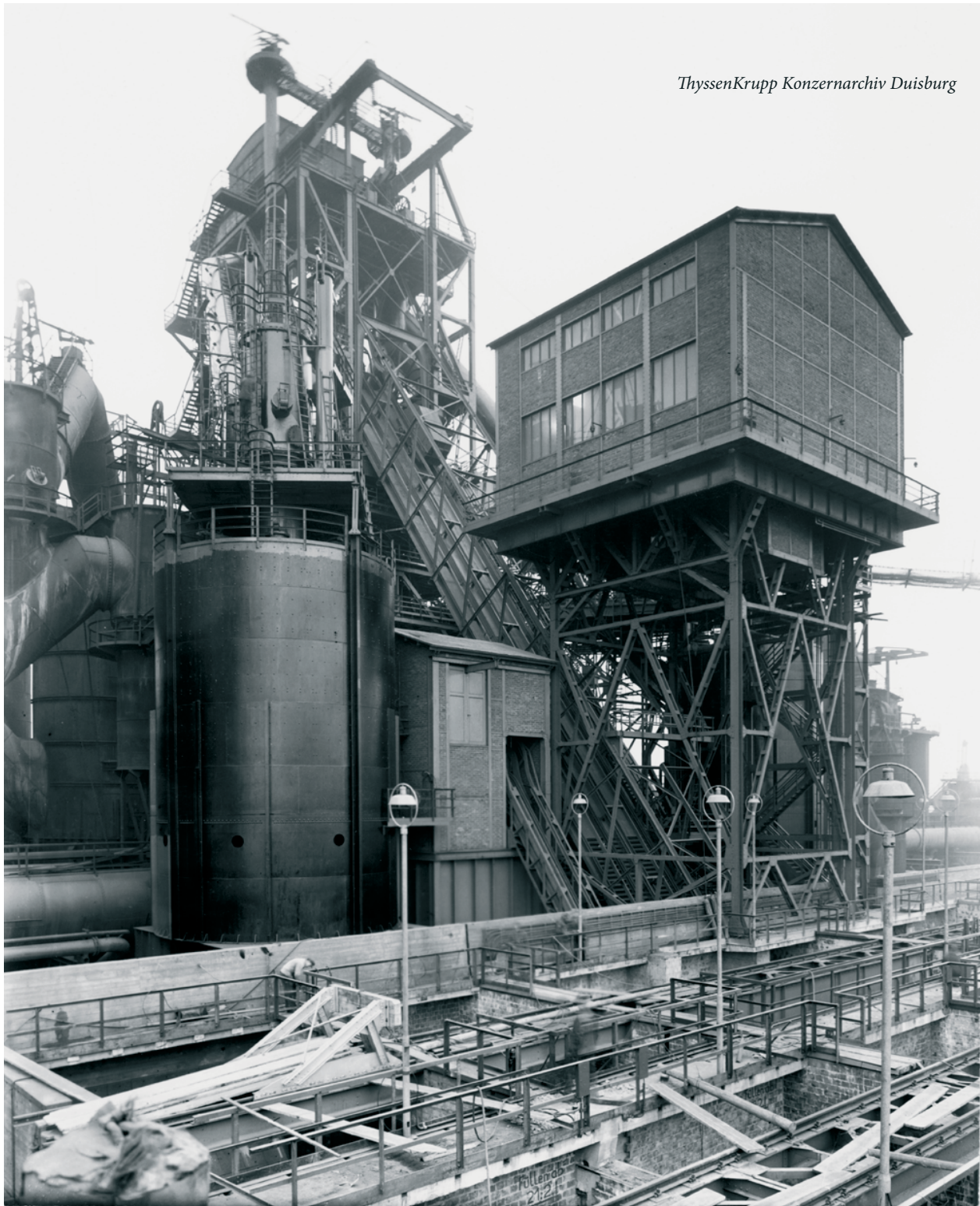
Abbildung 19: Hochofen 5 mit Schrägaufzug 1954, Quelle: ThyssenKrupp Konzernarchiv Duisburg
